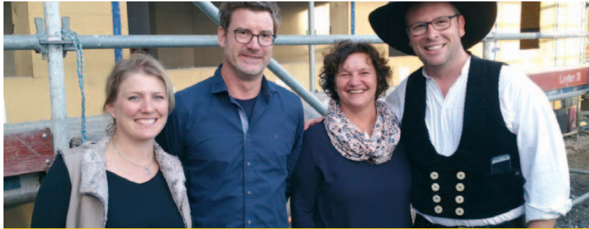
Der Rohbau steht: Jana Hempel, Fachbereichsleiterin Bauen und Umwelt, Architekt Christian Prokesch, Bürgermeisterin Ilona Volk und Bernd Kraushaar, dessen Firma die Holzfassade macht (von links) freuen sich beim Richtfest für die Kita Waldspitzweg Ende September.
