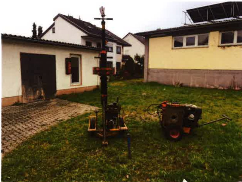
Baugrunderkundungen am 12. + 16. November 2021 - BS 1 / DPH 1
