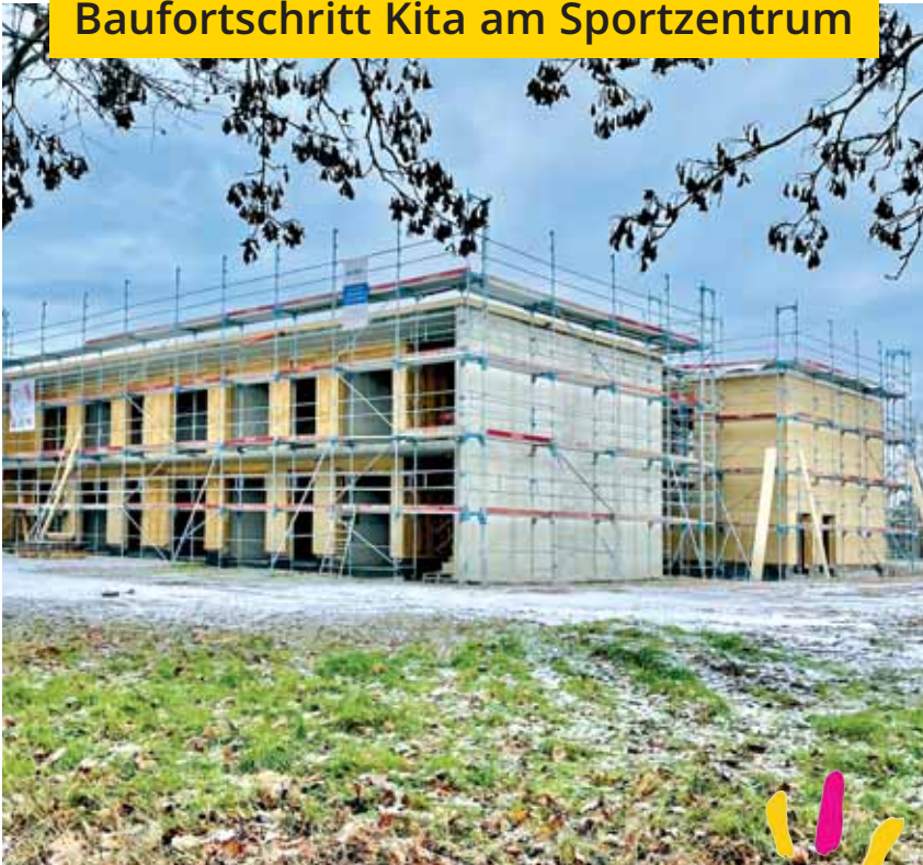
Großer Baufortschritt zu erkennen: Die neue Kita am Sportzentrum
