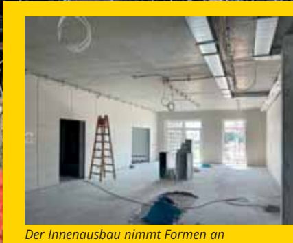
Der Innenausbau nimmt Formen an
